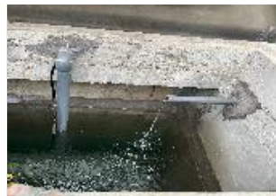
飲水機、空壓機、雨與玻璃清洗機排水匯流到50噸水池
