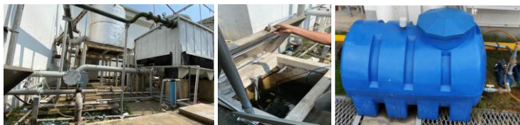
左圖 - 飲水機、空壓機、雨與玻璃清洗機排水匯流到50噸水池 / 中圖 - 夏天屋頂降溫 / 右圖 - 越南廠空調排放水回收裝置
